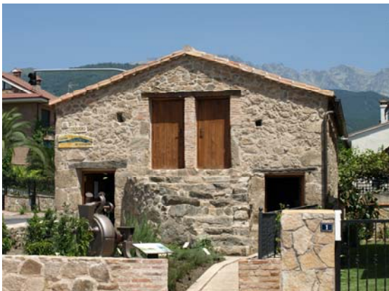
Centro de Recepción de Visitantes y Aula de Interpretación del Pimentón
